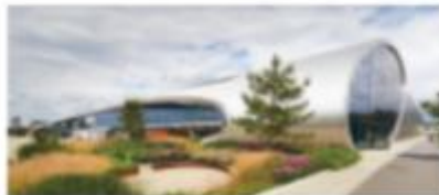
持続可能性に配慮した倉庫
